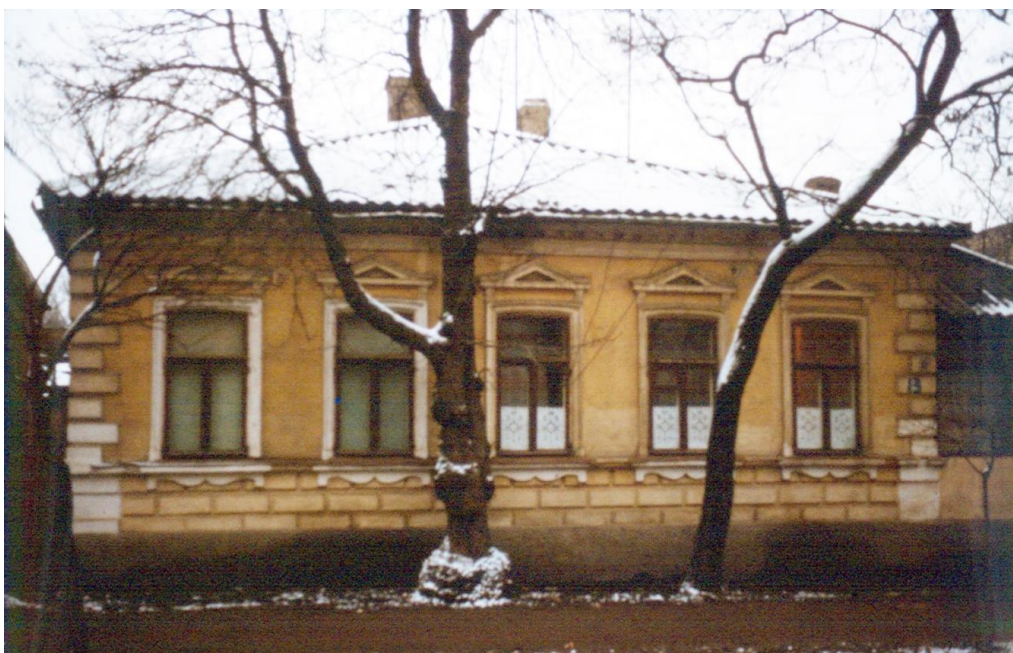
Anexa 5. Aspectul casei în 1990
