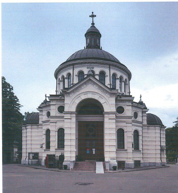
Fig. 1. Capela din Cimitirul Bellu
