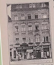
Das Wohnhaus der Familie Kästner in der Königsbrücker Straße von 1909 bis 1910
