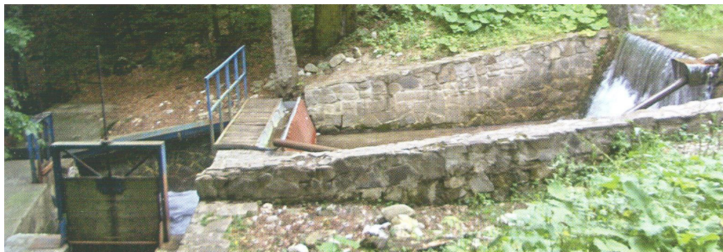
Fig. 3 Priza centralei hidroelectrice Peleş
