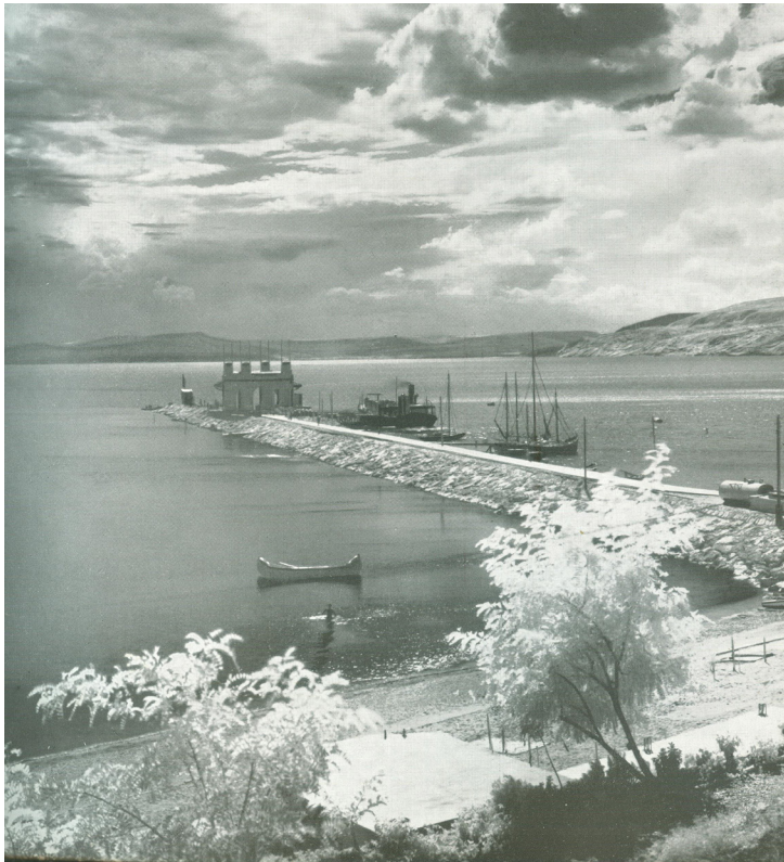
Fig. 4. Digul de la Balcic
