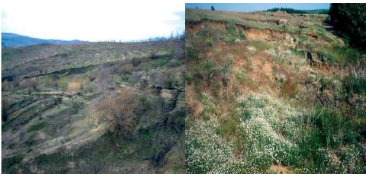
Foto 8.4. Alunecările de teren și eroziunea – rezultat al gestionării incorecte a solurilor
