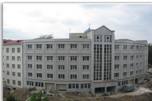
Corpul nr. 7 (în construcție)
