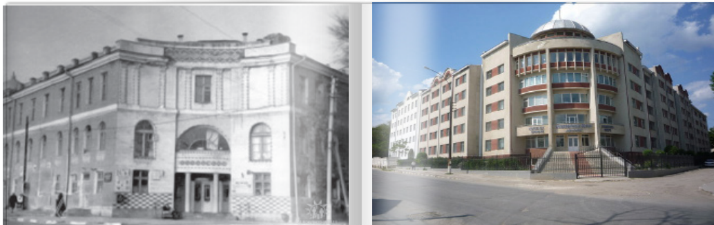
Corpul nr. 5, altădată - casă de deservire (baie, spălătorie, curățătorie chimică, frizerie, cizmărie, vopsirea și prelucrarea pielii și blănurilor)
