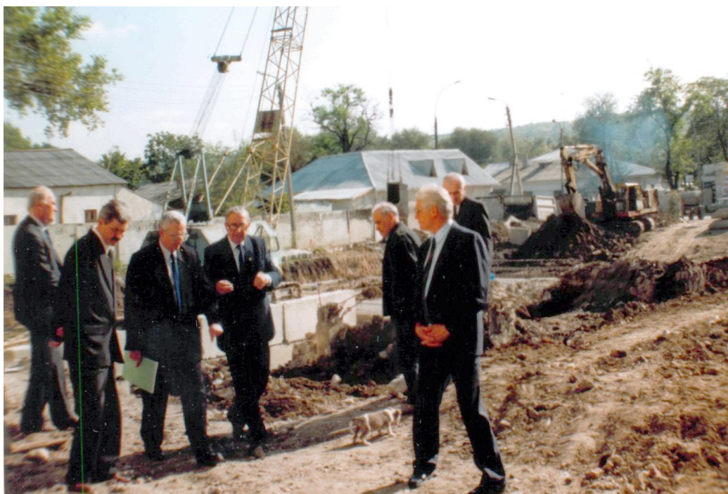
Anii '90. Pe șantierul de construcții a noilor corpuri de învățământ
