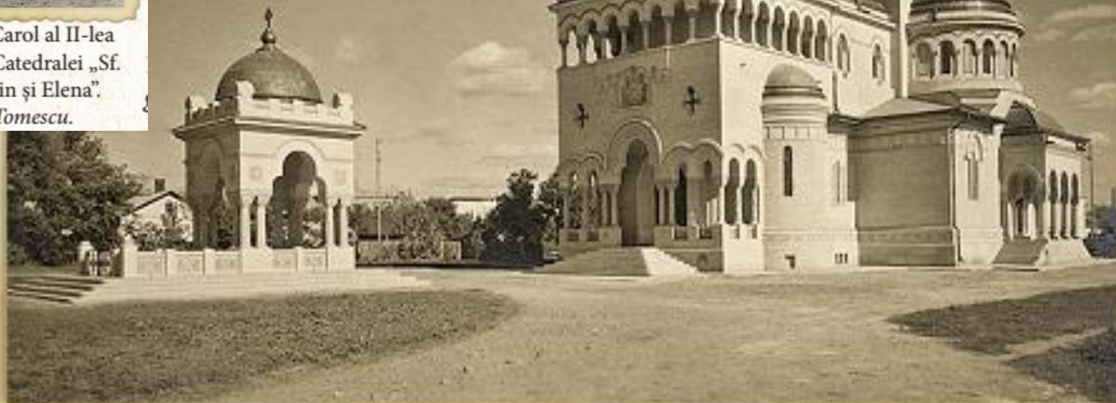
Punerea pietrei de temelie a Catedralei „Sf. Împărați Constantin și Elena” din Bălți. 1924. Imagine de C. Tomescu.
